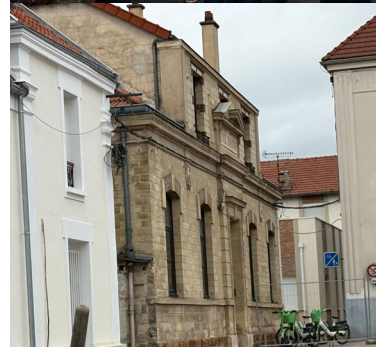
La place Roland Gauthier en cours de réaménagement
